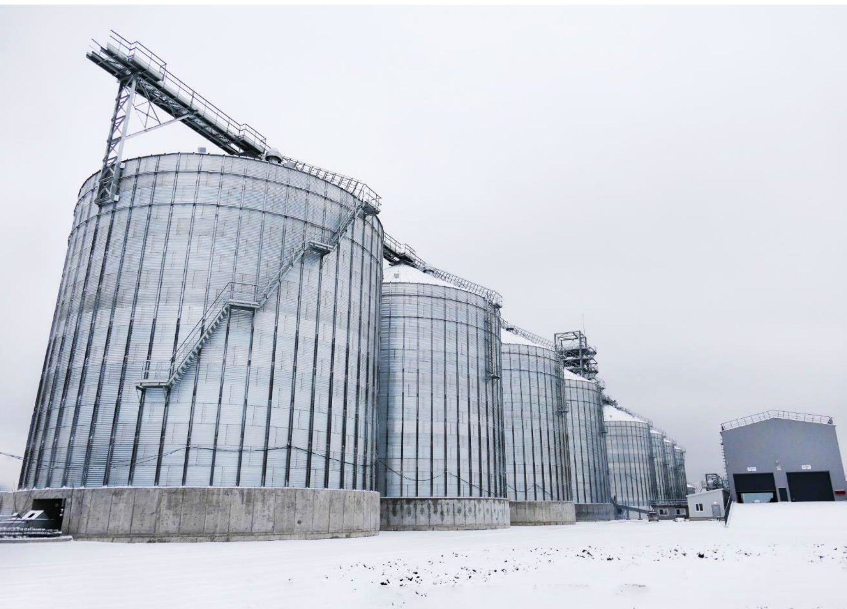
Строительство элеватора в Свияжске
